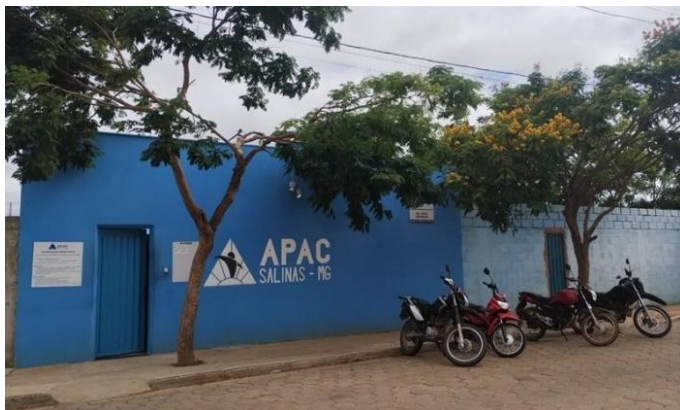
Figura 4.1: Fachada da APAC Salinas/MG
